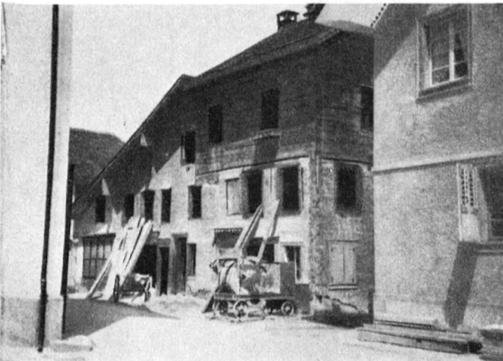
Südseite an der Landstraße zwischen «Röfli» und Post beim Abbruch im April 1929. Von der Bezirksgemeinde erworben den 13. Mai 1928.
