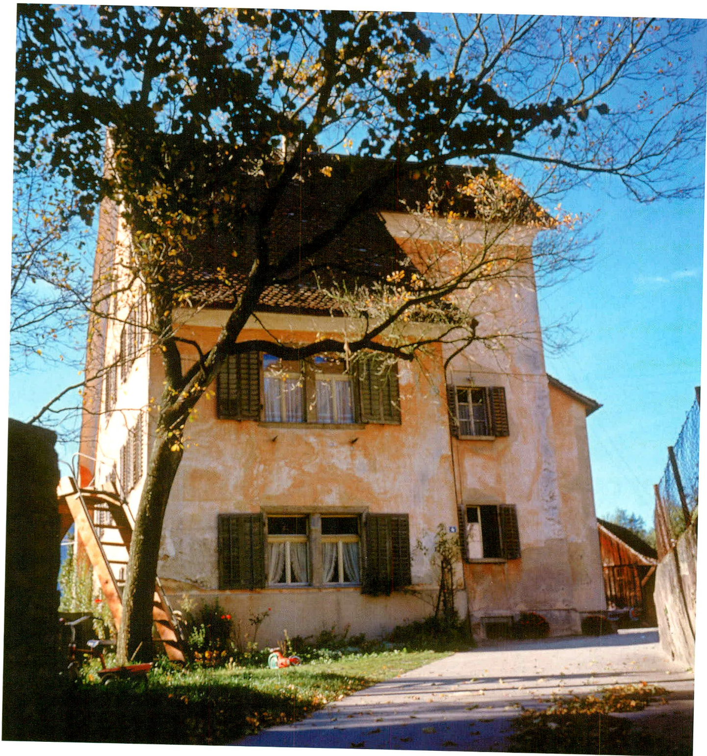
13 Haus im äusseren Vogelsang, Ansicht der Ostseite, Foto ca. 1970. Durchblick durch breite Mauerlücke an der Stelle des früheren Tores.
