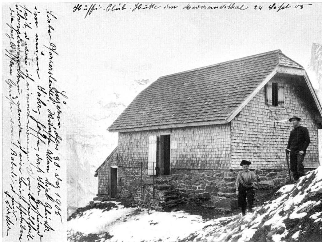
Die zweite Hüfihütte von 1899 als grosszügiger Holzständerbau von einheimischen Bauhandwerkern auf dem sog. Hüfistöckli ausgeführt. Zustand 1905.
