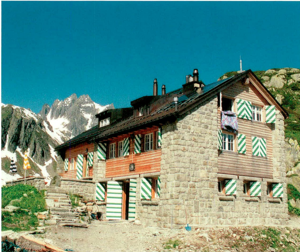
Die Etzlihütte nach dem Teilneubau 1999. Aufnahme 2001.
