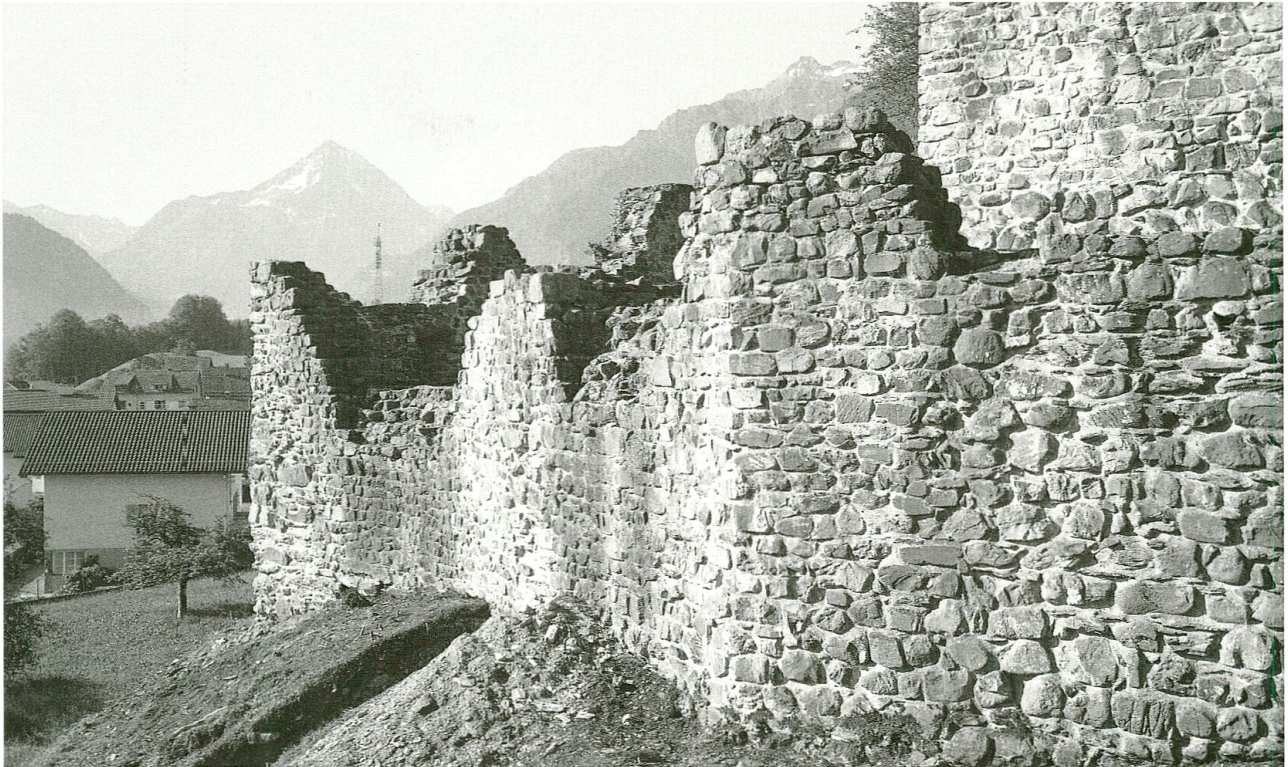
Umfassungsmauer. Original erhaltener Teil an der Ostseite. Foto Werner Meyer.
