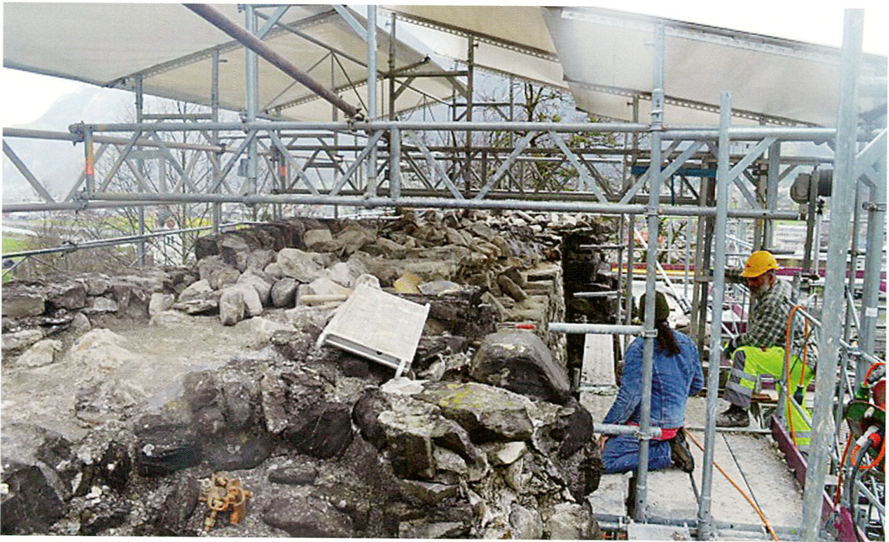
Zwei Fachleute auf dem Gerüst. Die Burg wurde nicht nur kunstgerecht restauriert. Das Mauerwerk wurde gleichzeitig wissenschaftlich untersucht. Aufnahme: Ulrike Gollnik, Moudon.
