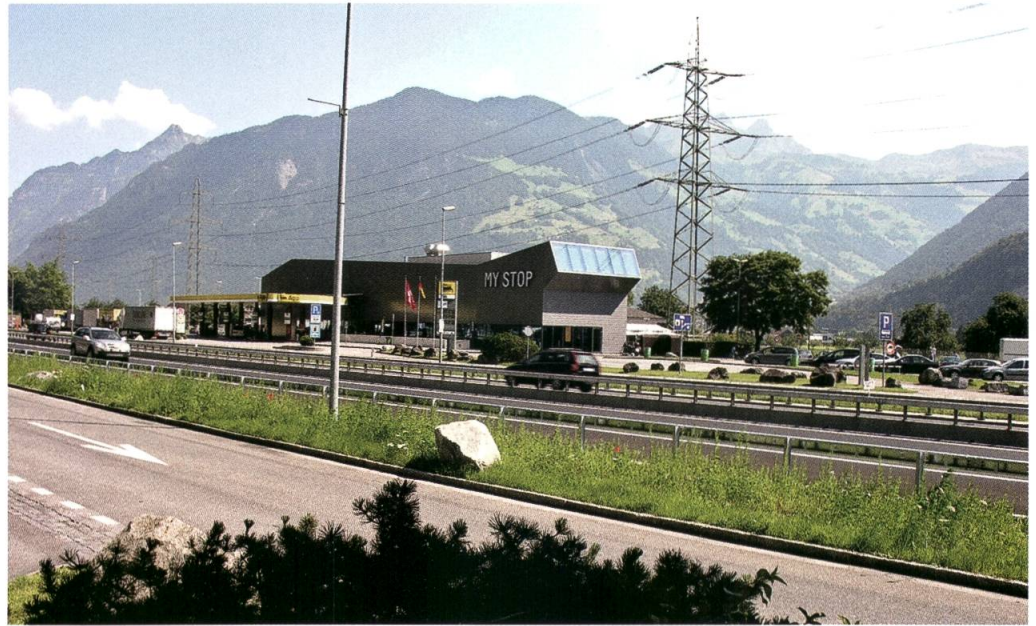
Nationalstrasse A 2 und Gotthardraststätte im Dimmerschachen, 2014. Foto Hans Stadler- Planzer, Attinghausen.
