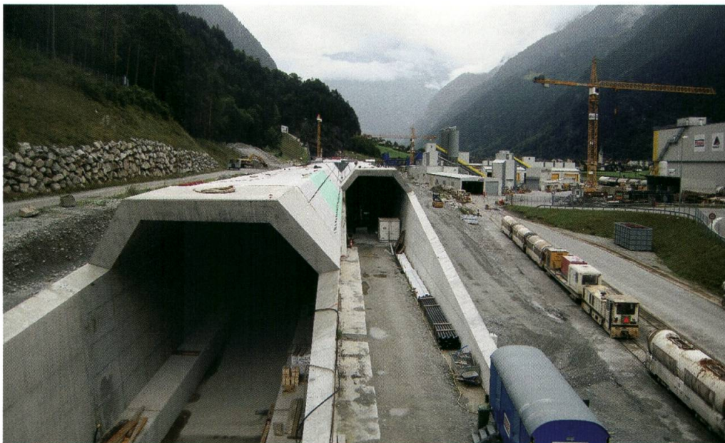
Nordportal der Neuen Eisenbahnalpentransversale (Neat) im Bau, 2013. Foto Hans Stadler-Planzer, Attinghausen
