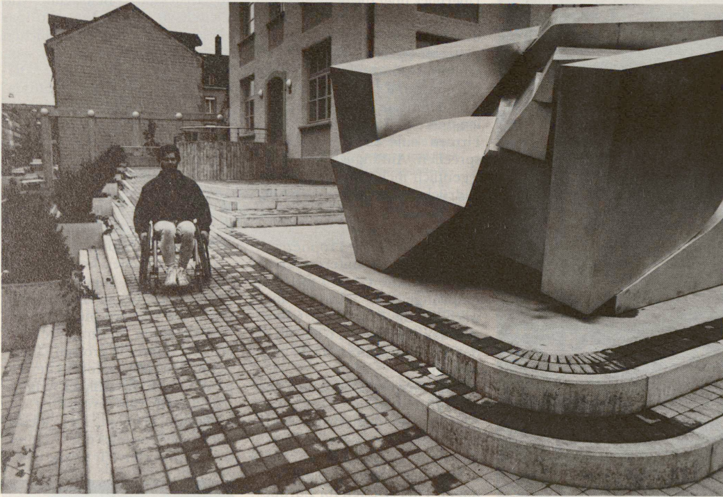
Optisch gut gelöste Änderung der Zufahrt zum Amtshaus Biel: Rampen statt steiler Treppe.
