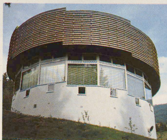
Der Rundbau der «Lichtplanung Christian Bartenbach» mit seinem System von prismatisch geschliffenen Scheiben, die keine blendenden Sonnenstrahlen hereinlassen. Auf dem Dach ein Forellenteich, dessen Abfluss als Bächlein das ganze Haus durchplätschert – eine natürliche Luftbefeuchtung.
