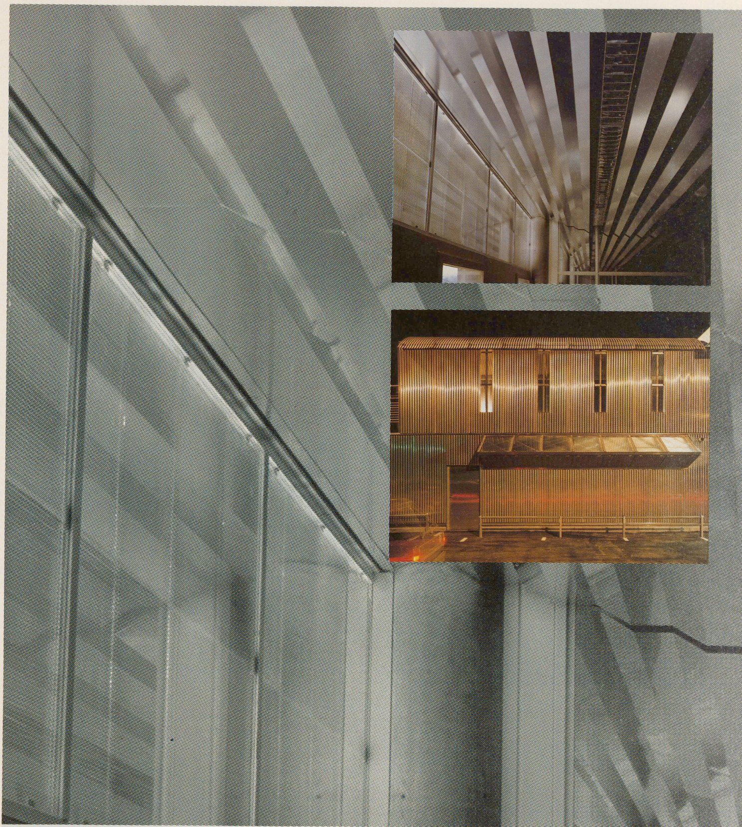
Das Lagerhaus des Berner Sportgeschäfts Vaucher (Atelier 5), für das Bartenbach eine der ausgefallensten Lichtlösungen gefunden hat: Ausragende Prismen, die das Tageslicht auffangen, prägen die Fassade aus gewelltem Alu-blech. Ein Umlenkensystem bringt das Licht ins Rauminnere. Die Fenster sind nur noch Bezugsöffnungen nach aussen.
