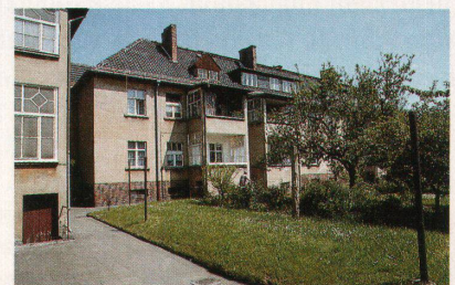
Erbschaft 2: Wohnen in Dessau-Nord. Das industrielle Gartenreich unterstützt eine sanfte Renovation.
