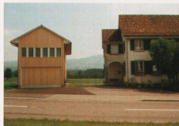
Renoviertes Schulensemble bei Hinwil
