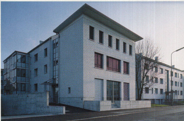
Aarepark Solothurn: ein Demonstrationsobjekt
