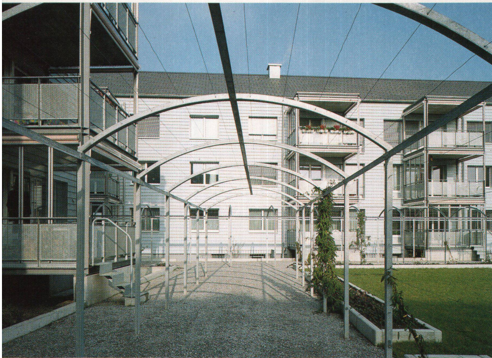
Die Pergola in den Höfen trennt die halbprivate Zone vor den Balkonen von der halböffentlichen des Hofinnern
