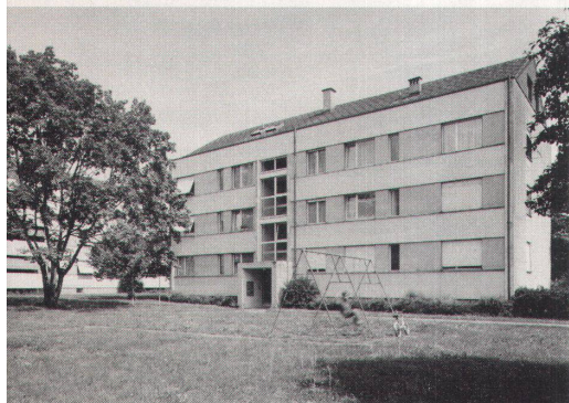
Fassaden der Überbauung vor der Sanierung: der spröde Charme der Cremeschnitten-Zeit
