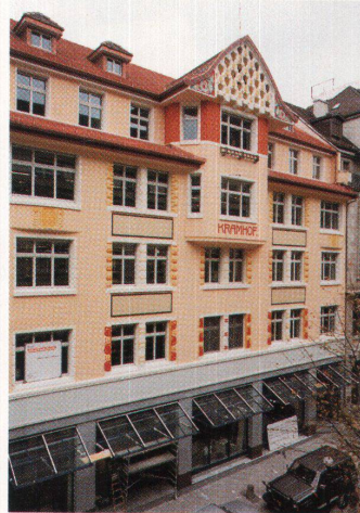
Jugend- mit Heimatstil an der Zürcher Bahnhofstrasse: Orell Füssli hat die «Kramhof»-Fassade restaurieren lassen
