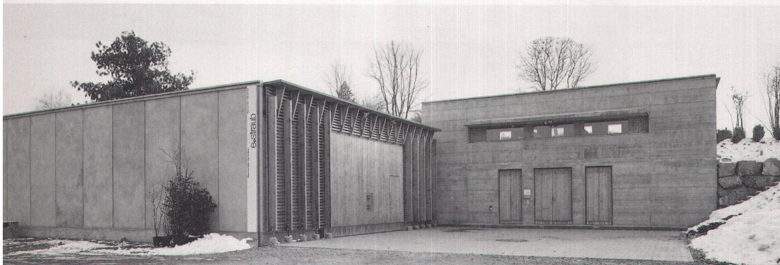
Blick von der Zugangsstrasse auf die Werkgebäude der Baumschule Straub in Freidorf TG. Links die Einstellhalle, rechts der Büro- und Werkstatttrakt
