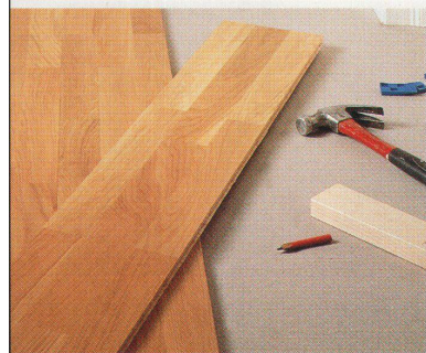
Schwimmend verlegtes Fertigparkett bei einer Renovation (Tarkett, Suhr)
