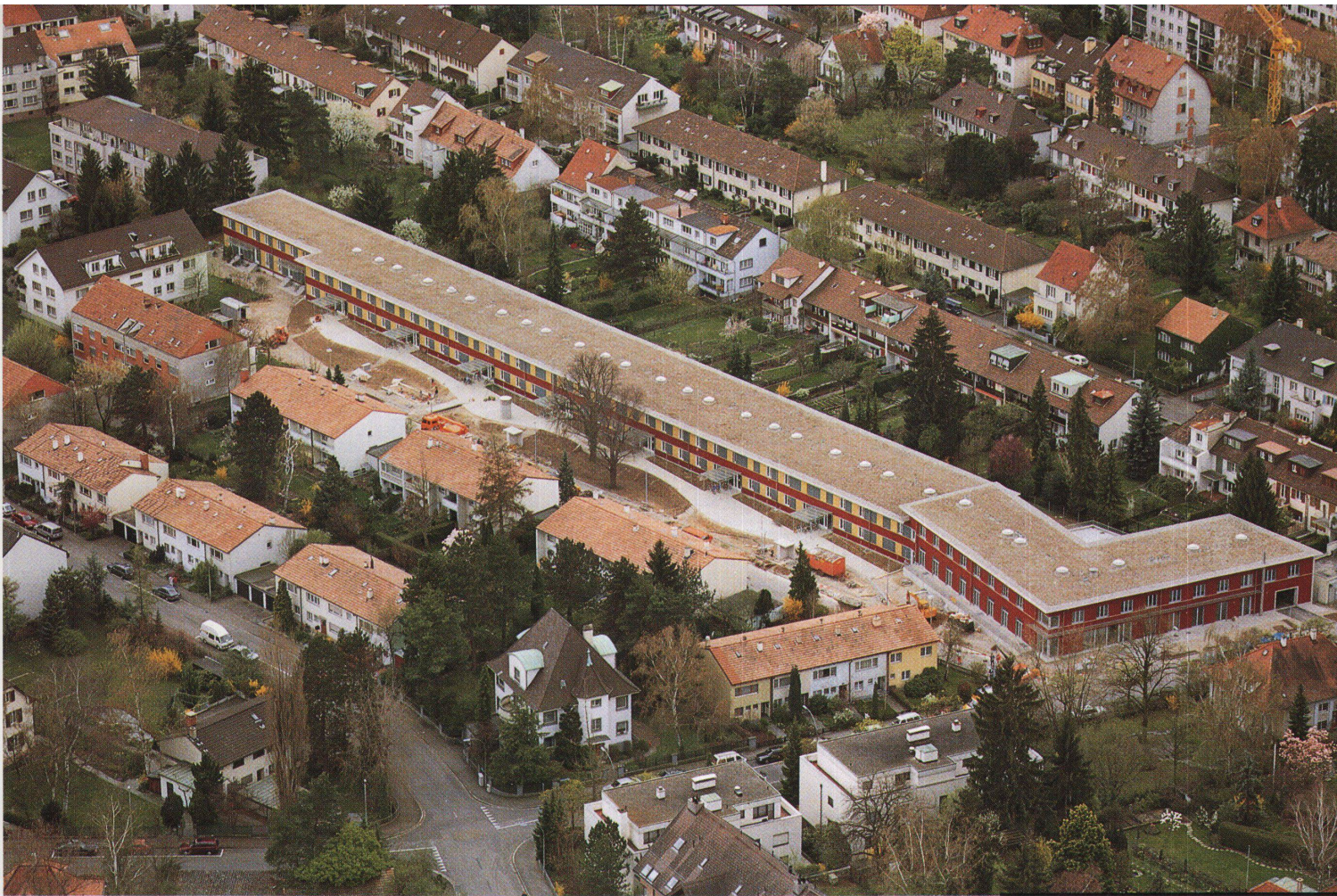
Die Siedlung «Im Niederholzbode» in Riehen bei Basel. Die Luftaufnahme zeigt deutlich die drei Abschnitte der Zeile: Kopf, Körper und Schwanz
