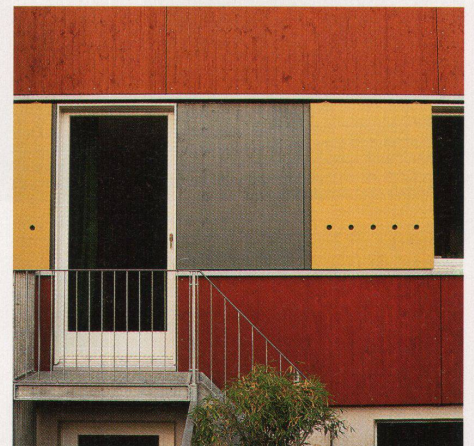
Gartenaustritt aus dem Schaltzimmer
