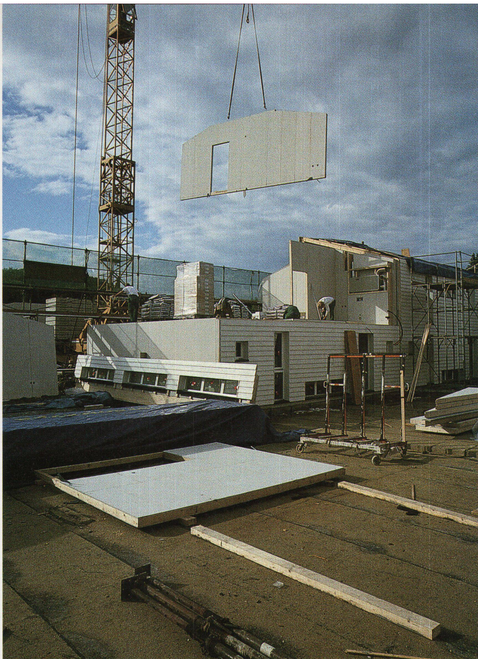
Die Montage eines Hauses erfordert einen einzigen Tag (rechts)
