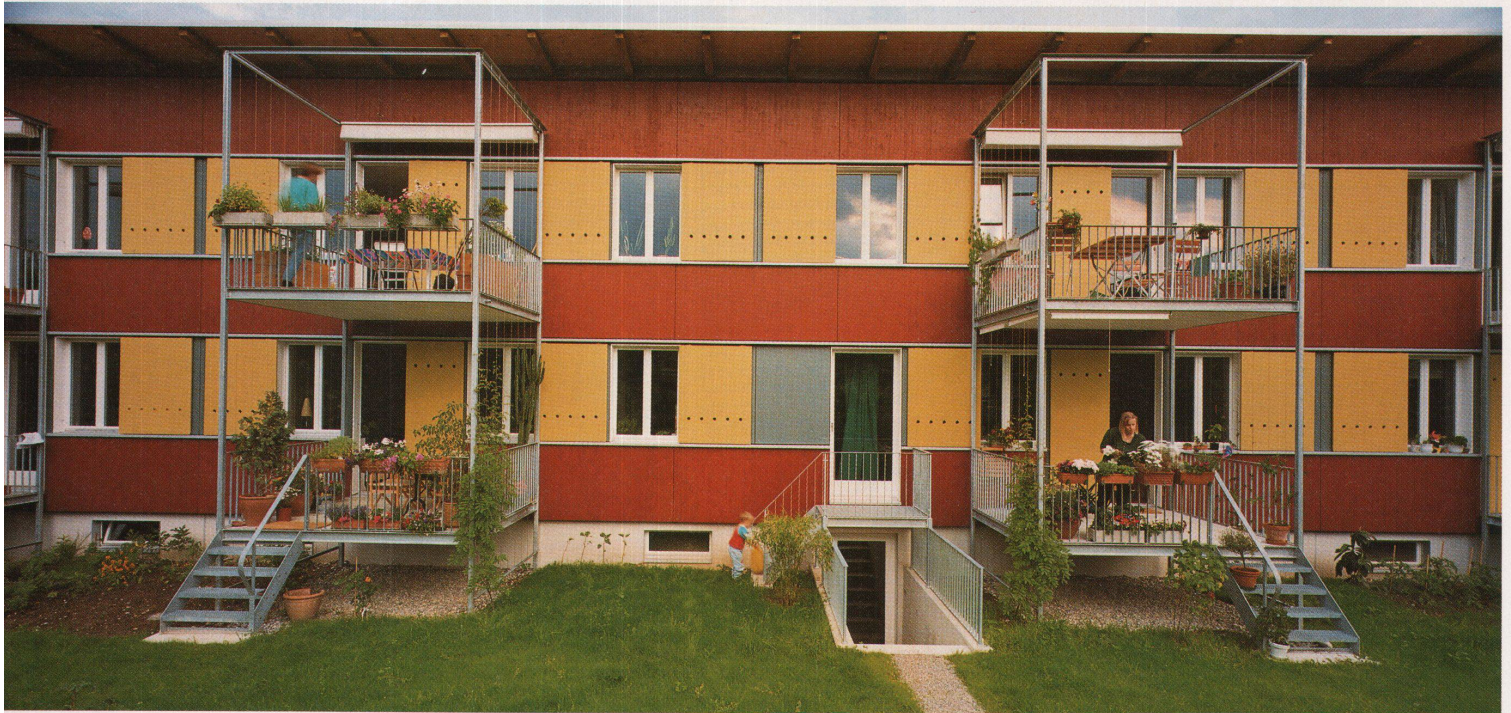
Gartenfassade. Jede Wohnung verfügt über einen grosszügig bemessenen Balkon
