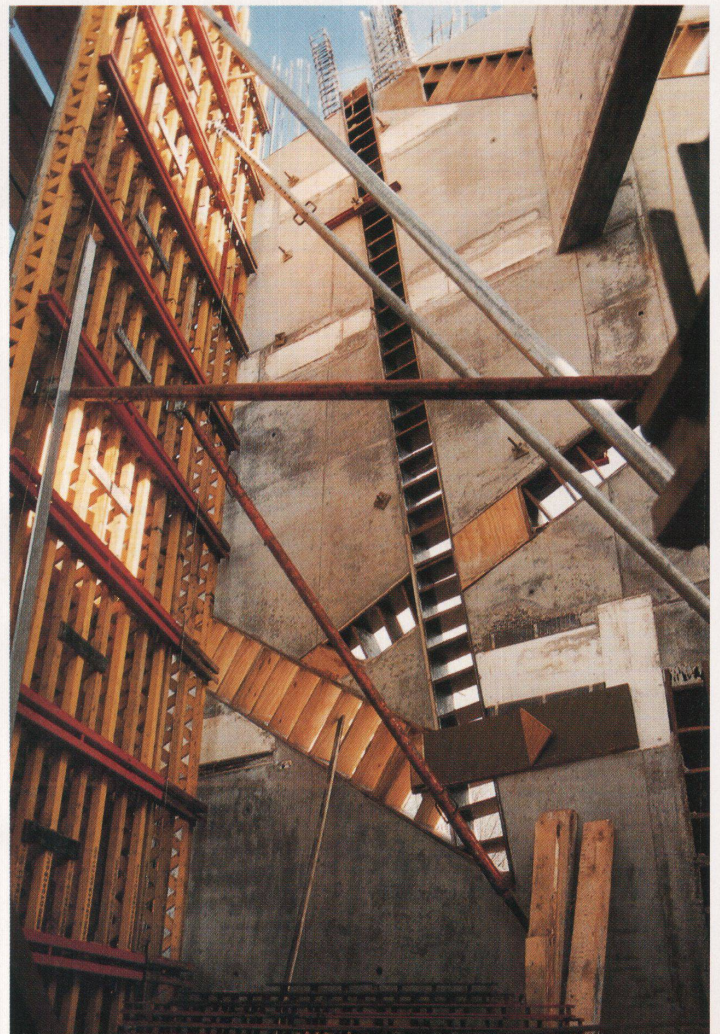
Neu sind die Bilder von Libeskind-Baustellen: Blick ins werdende Berlin-Museum, Abteilung Jüdisches Museum
