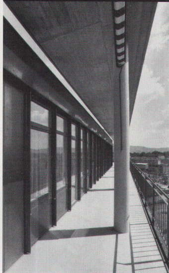
Auf der Süd-Ost und Süd-West Seite schaffen Bettenbalkone zusätzliche Räume
