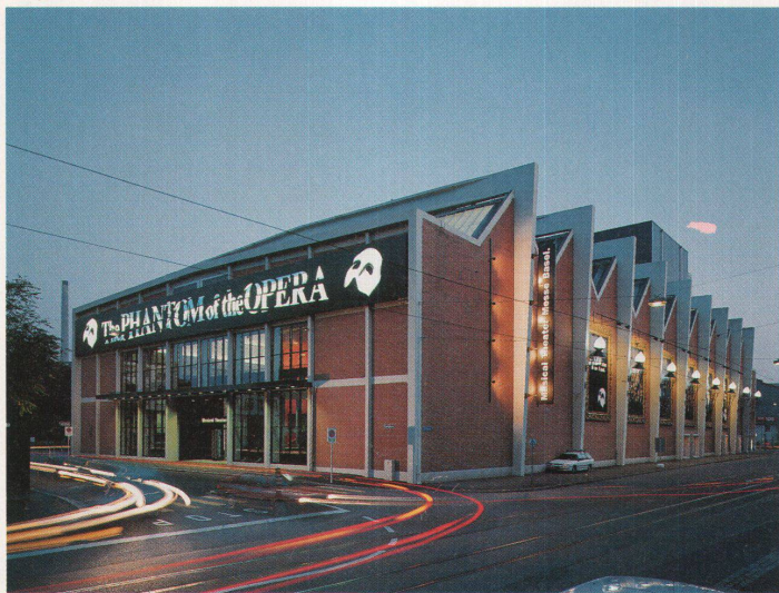
Aus der Ausstellungshalle 107 wurde ein Theaterhaus
