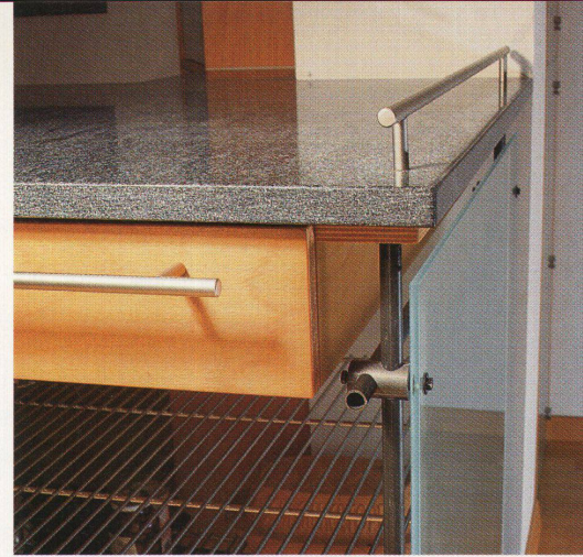
Sorgfalt der Konstruktion und alltägliche Brauchbarkeit: Ein Rohrgerüst trägt die Arbeitsfläche, und ein «Geländer» verhindert das Herabfallen von Gegenständen
