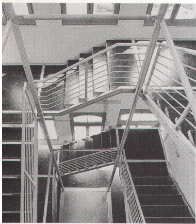
Die Treppenanlage im Turmbau: Hier kann später auch ein Lift eingebaut werden
