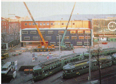
Für das Dienstleistungszentrum wurden vorfabrizierte Holzbauteile verwendet
