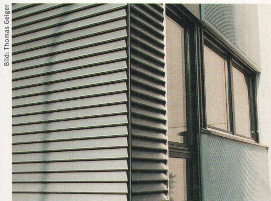
Die Stirnfassaden wurden isoliert und mit einer geschuppten Metallverklei- dung versehen
