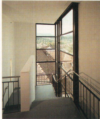
Der Korridor im Erdgeschoss verbindet den Neubau mit dem alten Saalbau
