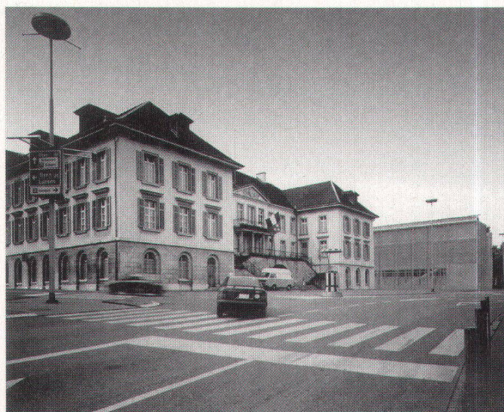
Der Neubau verdeckt das bestehende Kunsthaus und verändert damit das gewohnte Bild völlig
