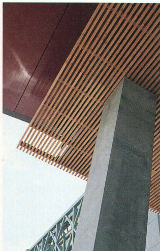
Auch an einem Bahnhof ist Holz ein modernes Baumaterial
