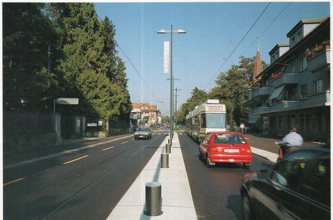
Fussgänger kommen dank einer erhöhten Mittelzone sicher über die Strasse
