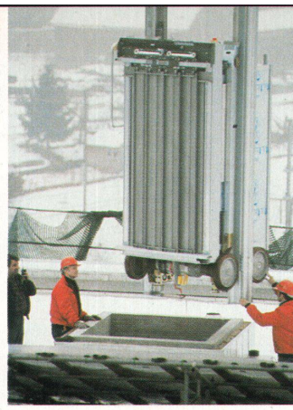
Die Kabine wird samt Tragkonstruktion vom Kran in den Liftschacht versenkt
