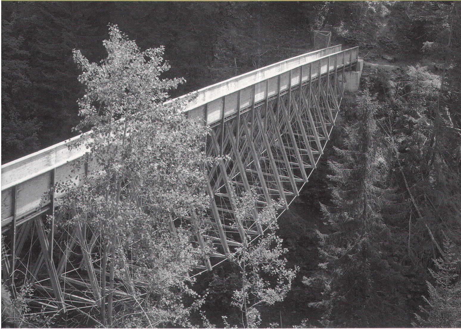
Die Brücke an der «Veia Traversina» in der Viamala: Steg, Gurte und Fachwerk halten die Konstruktion zusammen, montiert wurde sie per Helikopter
