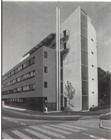
Langgezogener Bürotrakt, der den Strassenraum definiert, dahinter der Erschliessungsturm als Übergang zum konvexen Bürotrakt
