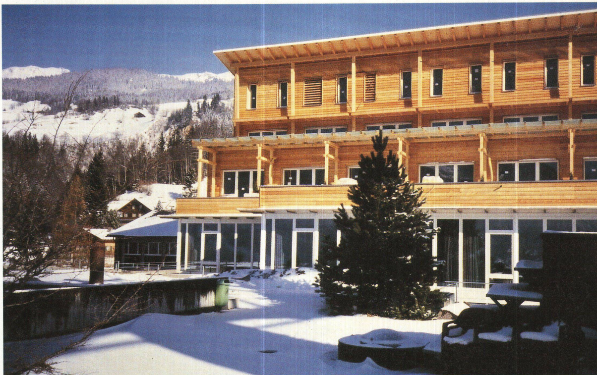
Das neue Hotel Viktoria (1996) in Hasliberg-Reuti der Architekten Hergtig und Partner, Aarau. Die einfache Holzarchitektur erinnert an Ferienhaus und Kurhotel
