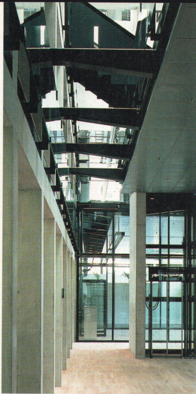
Blick im Erdgeschoss in die Trennfuge zwischen dem Stahleinbau und der Büroschicht längs der Geraden. Die Architekten spielen mit überraschenden Durchblicken
