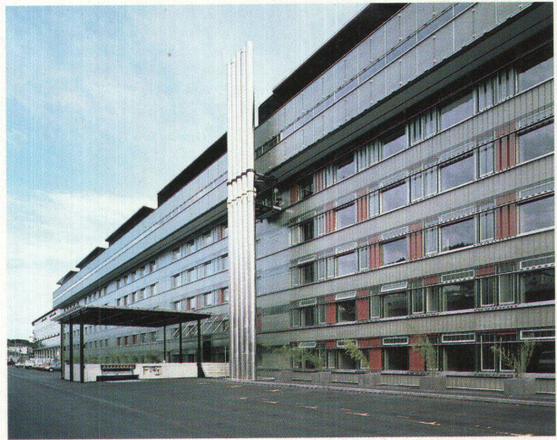
Die Gerade. Unten die fünf Bürogesschosse mit der Profilfassade, darüber die Auskragung des Dachgeschosses
