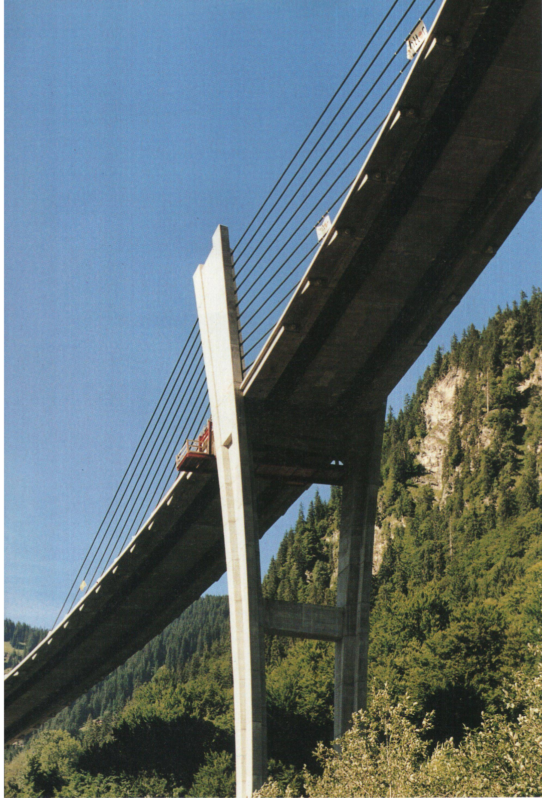
Blick auf den zweiten von vier Pfeilern (links) und ein Detail der Verankerung der Tragseile im Pylon (unten). Insgesamt 50 t Vorspannkabel halten die Fahrbahn
