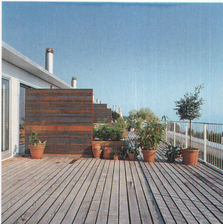
Ein Dachaufbau mit Wintergarten und Balkonen mit Blick auf den See
