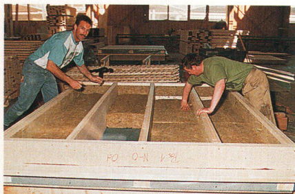
Einbau der 350 mm starken Mineralfaserdämmung in das Wandelement
