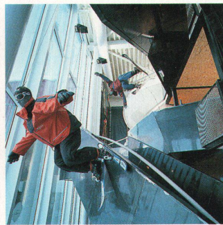
Zwischen Hülle und Ausstellungsgerüst steigt eine blechverkleidete Treppe in die Ausstellungsebenen
