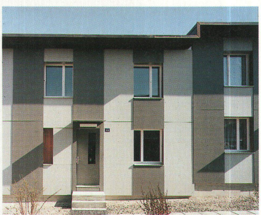
Die Zebrastrifenfassade: Geschosshohe Eternitplatten schützen die Ständerkonstruktion vor der Witterung
