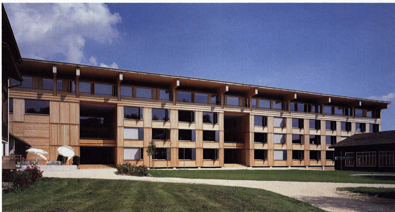
Ein viergeschossiges hölzernes Schulhaus – das ist heute möglich
