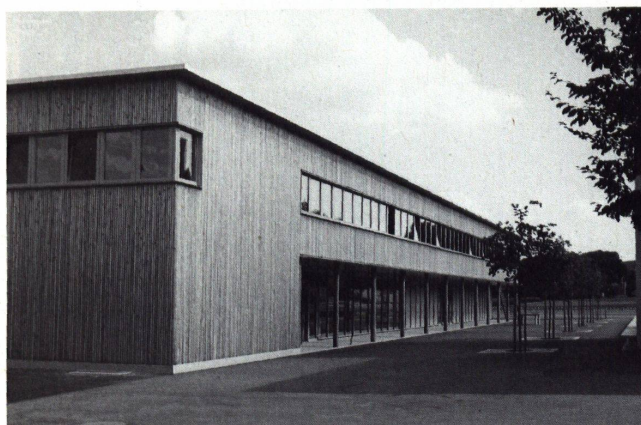
Die Eingangsseite des neuen Schulhauses
