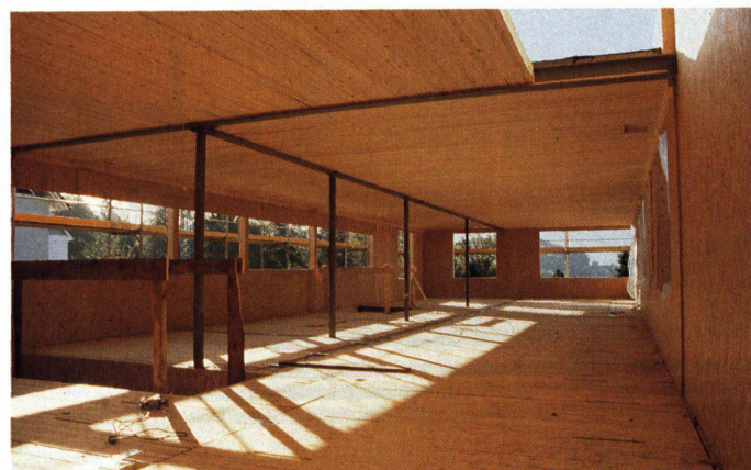
Im Rohbau: Die Decken bestehen aus Brettstapeln. Das sind hochkant stehende Bretter mit Hartholzdübeln zu flächigen Elementen gefügt
