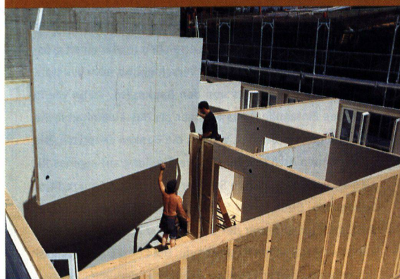
Montage der Innenwände
