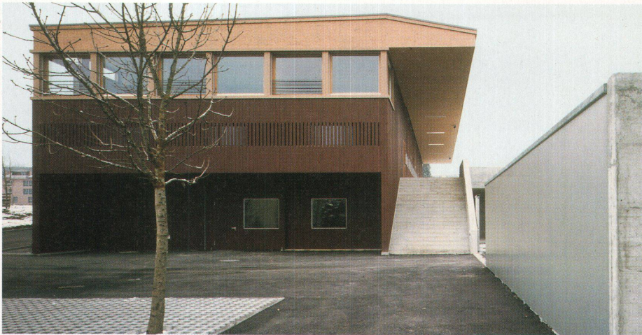
Untergeschoss und darüber liegender Bürotrakt aus Beton in Holz verkleidet, die dahinter liegende Halle und das Vordach aus Holz. Rechts die Sammelhalle
