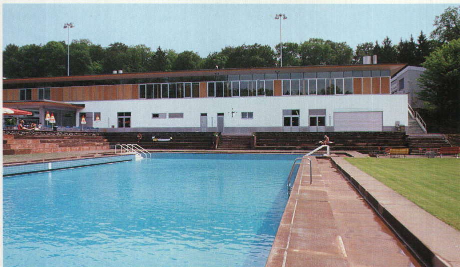
Der Hauptbau vom Wellenbad aus gesehen. Sockel mit technischen Anlagen, darüber das Restaurant
