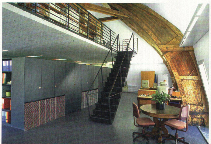
Büros auf dem ehemaligen Heuboden, gut sichtbar die alten Brettschichträger. Die Galerie aus Beton dient als Lager und Raum für die Haustechnikzentrale
