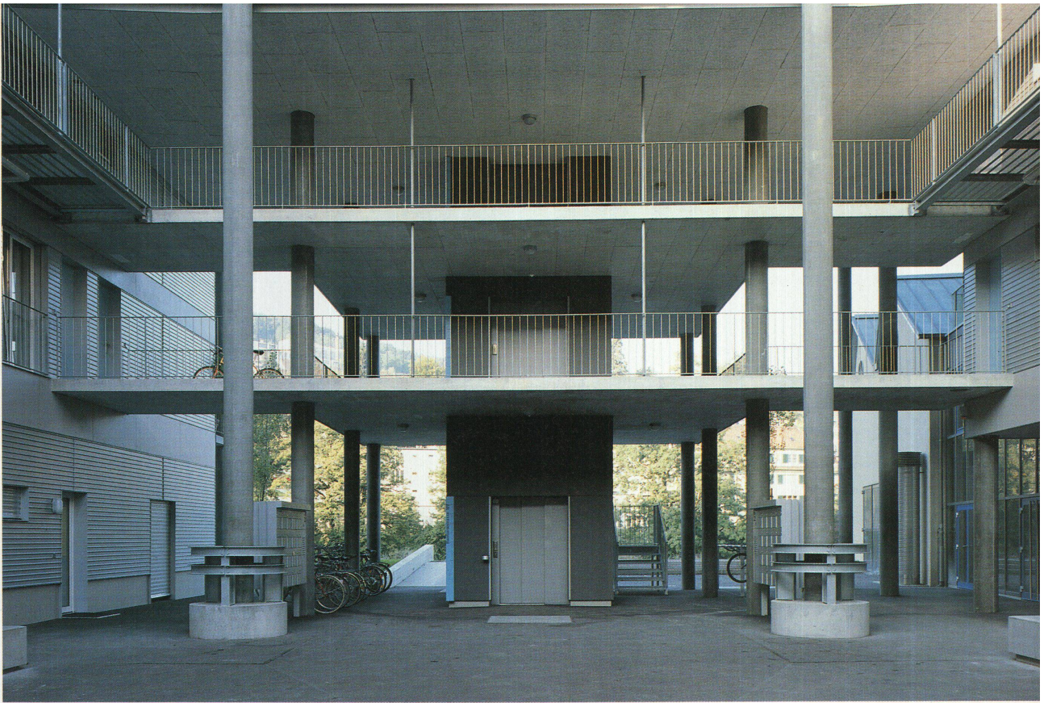
«Flussfenster» im Erschliessungshof. Rechts die Mehrzweckhalle
