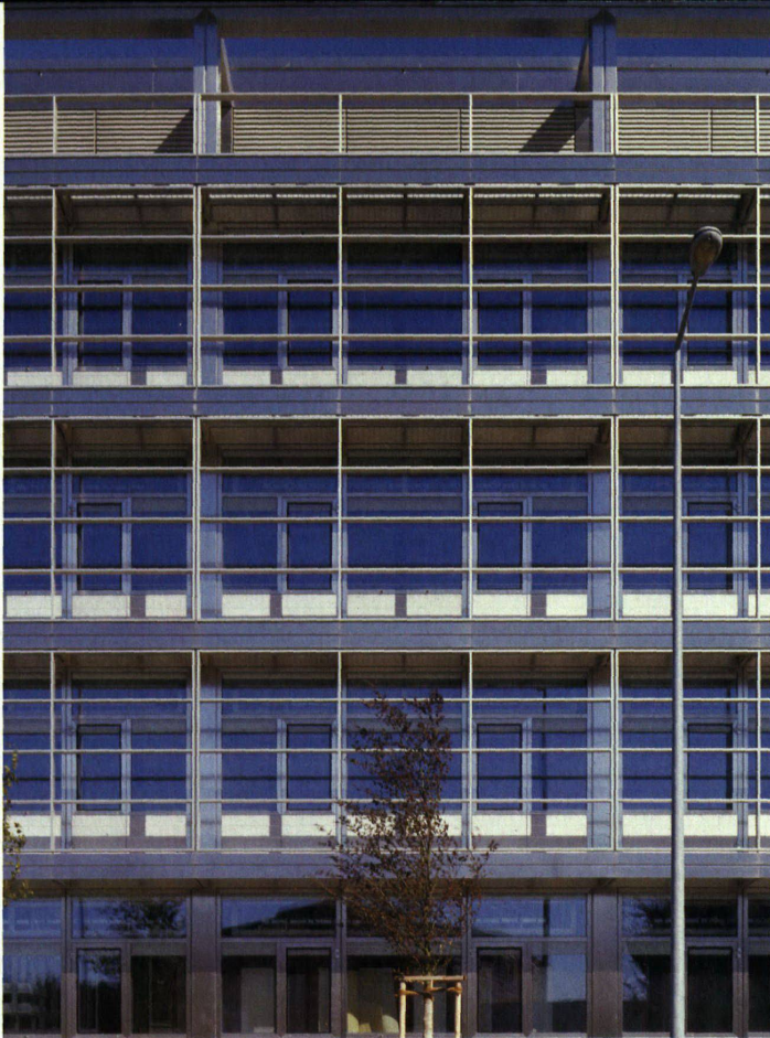
Mit einem Grundelement lassen sich alle nötigen Fassadentypen herstellen. Hier jene mit Fluchtbalkon vor den Laboratorien
