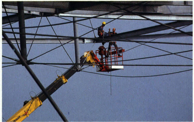
Yverdon – der Ort der Sorgen – ist der spannendste Bauplatz der Expo.02. Im See entsteht der Träger der «Wolke». 12 500 Düsen oder 31 000 Düsen? Die rollende Pilaug wird entscheiden
