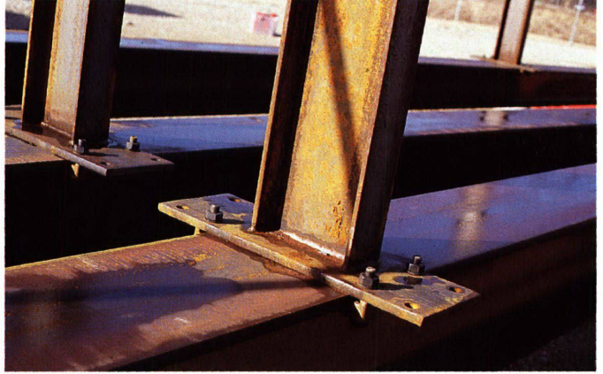
2 Das Stahlgerüst zweier Plattforelemente auf der Baustelle in Cornaux
