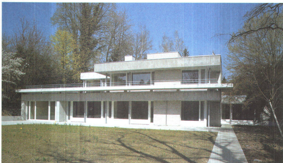
1 Die Residenz des liechtensteinischen Botschafters erhielt den Glanz der Sechzigerjahre zurück. Regina und Alain Gonthiers neuer Esssaal im linken Flügel fügt sich gut in den ursprünglichen Bau von Jean-Pierre und Tatiana Decoppet ein.
