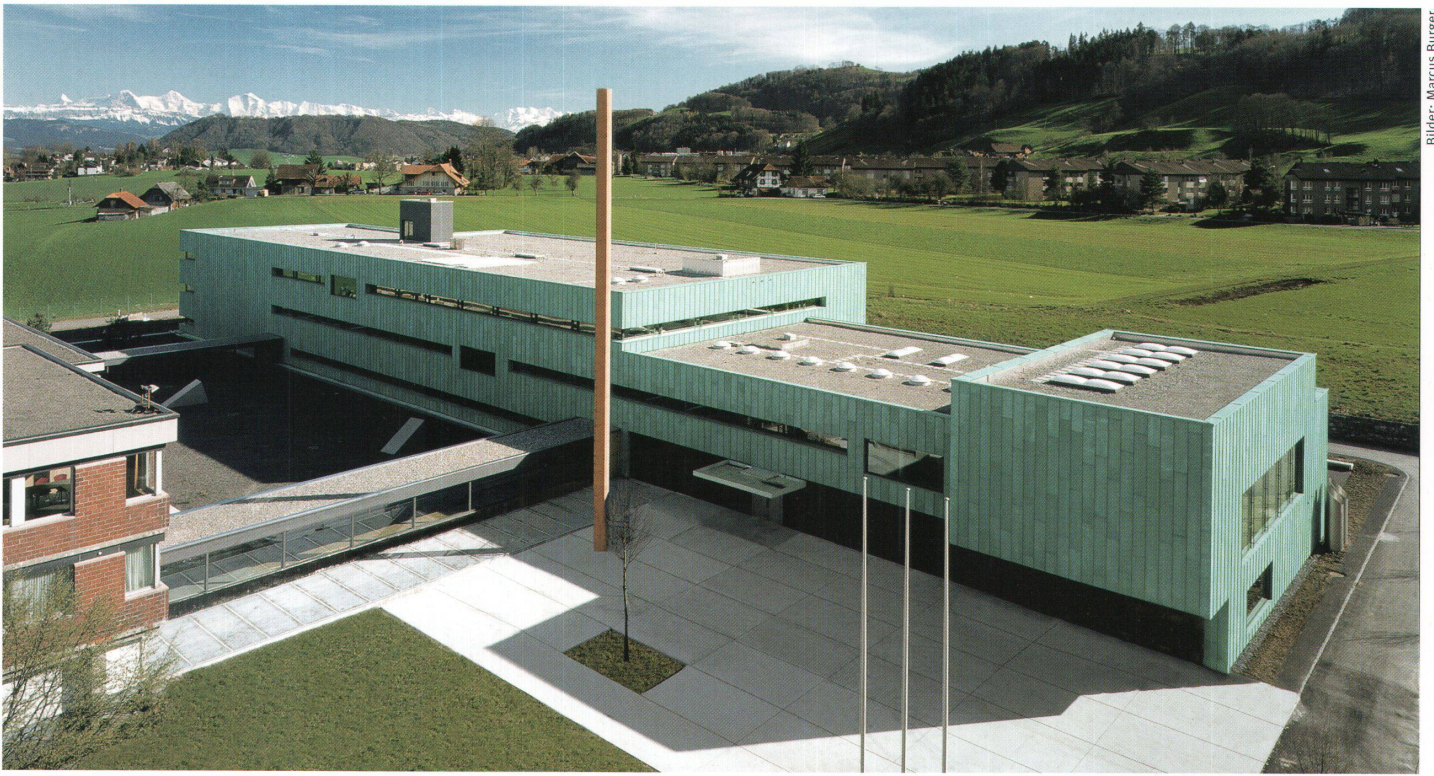
Blick vom Turm des Altbaus. Vorne der Eingangshof mit der vergoldeten Stele. Unter dem Hof links, der von zwei Glaspasserellen eingefasst ist, liegen die unterirdischen Laborräume
