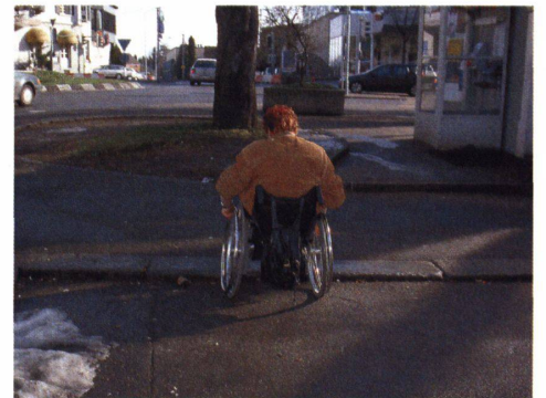
19 Als Fussgänger bemerkt man sie kaum, aber für die Rollstuhlfahrerin ist diese Schwelle ein Hindernis.
