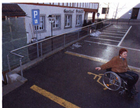
32 Von diesem Parkplatz sind es hunderte von Metern bis zum Eingang (hinten); zwei Treppen liegen dazwischen.
