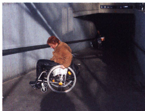
9 Diese Rampe beim Bahnhof Wil ist nur im Zickzack zu bewältigen. Auf einer Seite fehlt ein Lift.
