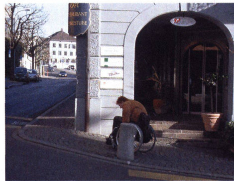
30 Gute Lösung: Das Restaurant Sonnenstube hat dank zurückgesetzter Tür einen ebenerdigen Zugang.
