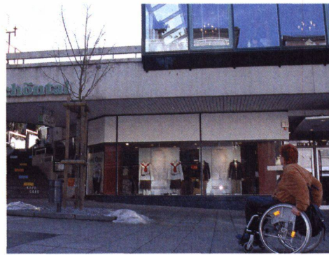
27 Ins Café Schöntal auf der oberen Shopping-Ebene führt von der Strasse weder ein Lift noch eine Rampe.
