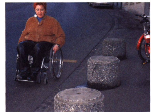
34 Diese Poller beim Hirschen zwingen die Rollstuhlfahrerin vom Trottoir auf die Strasse.
