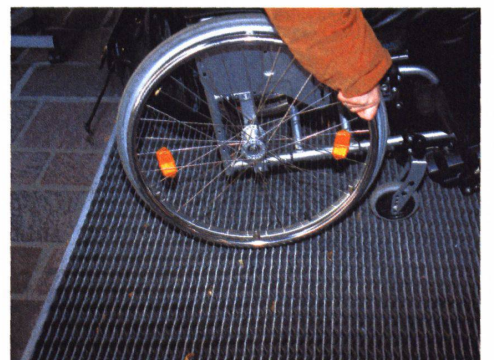
46 ... wie diese Türvorlage, welche dank eingearbeiteten Metallprofilen nicht zur «Bremsfalle» für Rollstühle wird.
