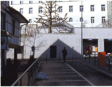
35 Vom Viehmarktplatz führt ein Lift zur oberen Altstadt. Beim Lift befindet sich eine öffentliche WC-Anlage.
