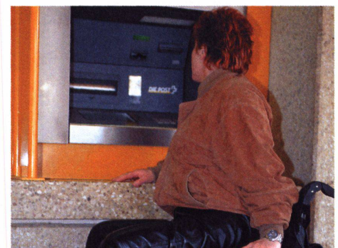
10 Es wäre nicht teurer, diesen Postomaten so einzubauen, dass ihn die Rollstuhlfahrerin bequem bedienen könnte.
