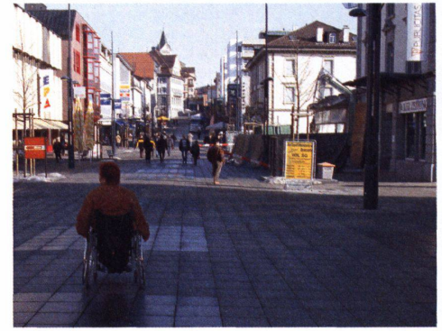
25 Auf diesem Plattenbelag rollt sich angenehm. Und die Rillen geben Blinden Orientierung.
